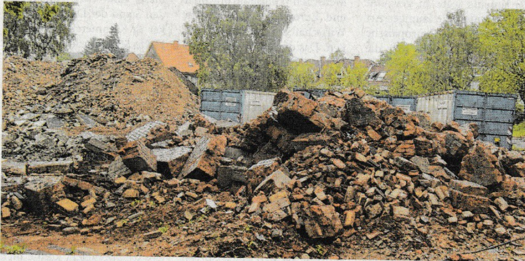
Jede Menge Schutt: Die Abbrucharbeiten auf dem zukünftigen Gelände von „Lidl“ und „dm“ sind abgeschlossen. Jetzt müssen die Reste nur noch abgefahren werden.
